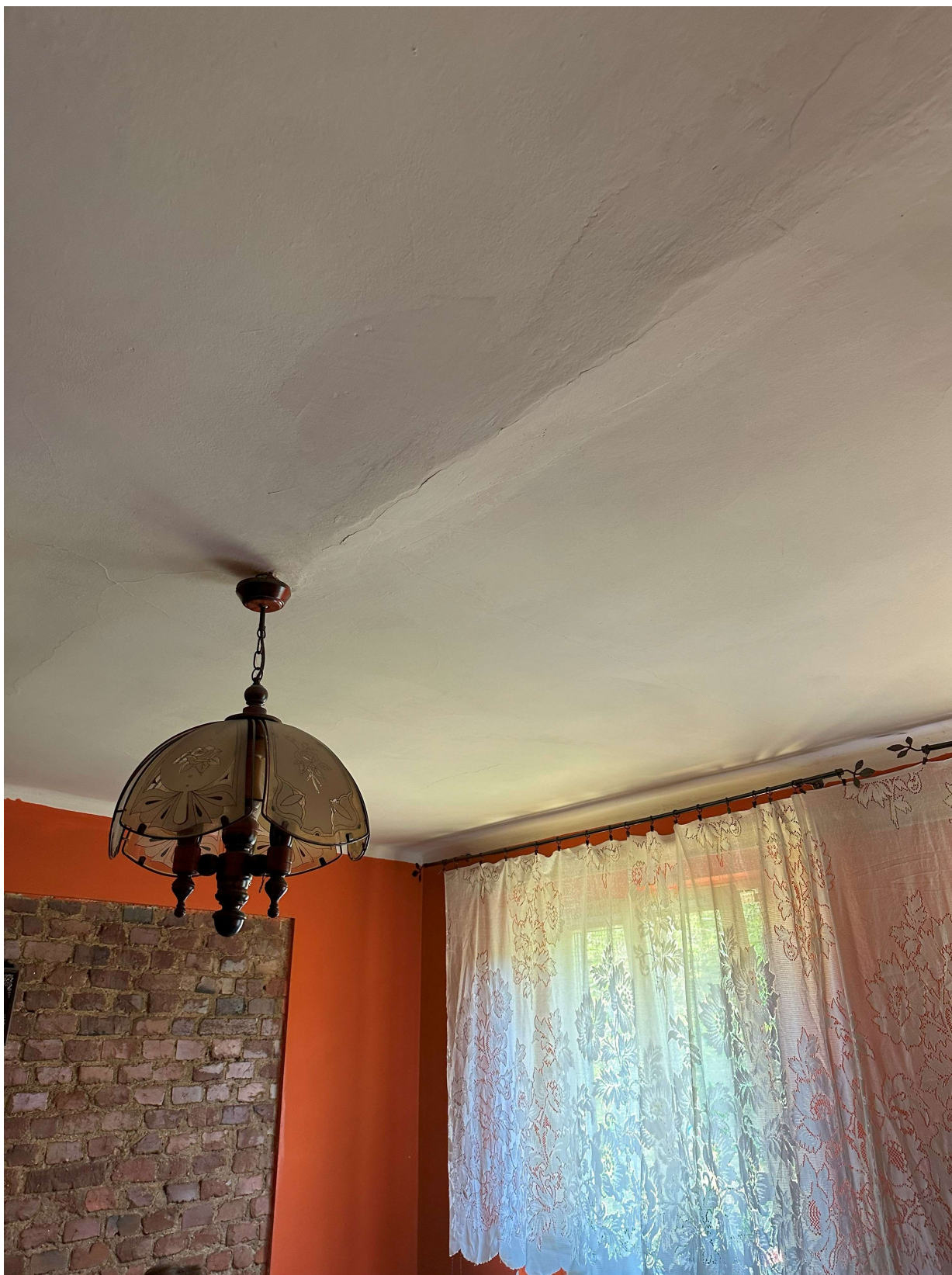
pęknięcie stropu
